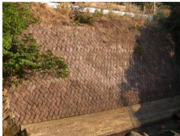
写真 17 溶結凝灰岩の石積み
