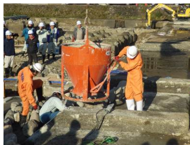
コンクリートの流し入れ作業
