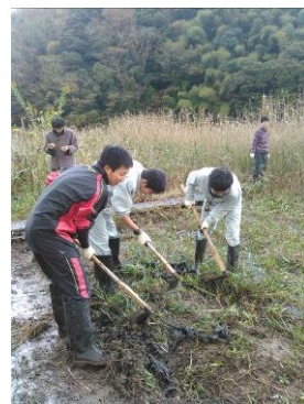
水路の造成(1年目)
