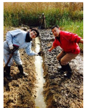
完成した水路(1年目)
