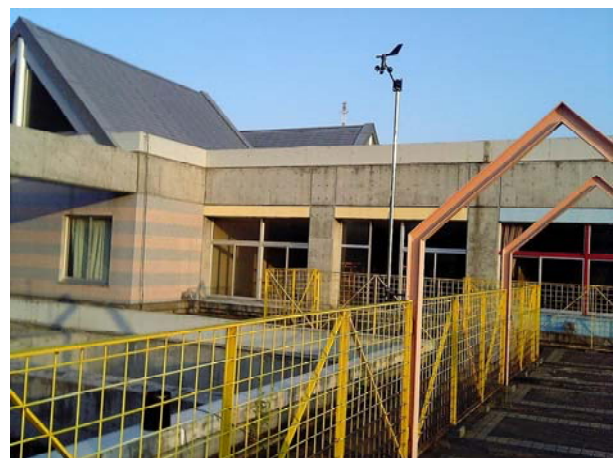
【図5 屋上に設置された気象観測システム】
