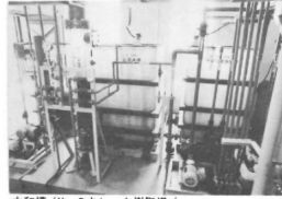
中和槽 / No. 2 キレート樹脂塔 / 処理水槽 / ドレイン廃液受槽
